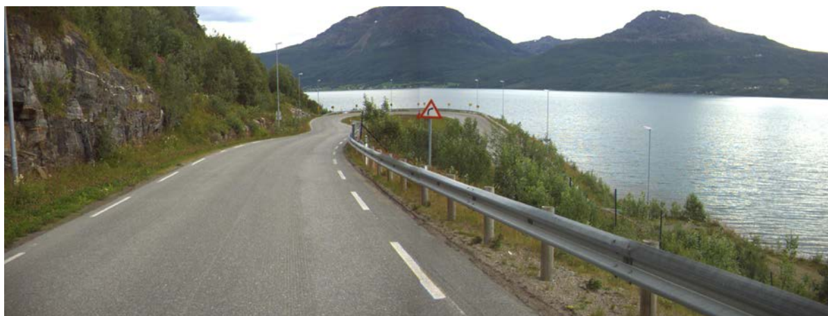
Bilde 10: Sørvik mot Ibestadtunnelen (NVDB)
