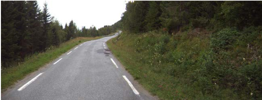
Bilde 3: Dagens veg ved Sæterberget (NVDB)
