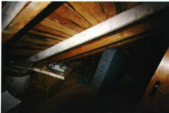
Takkonstruksjon gamle del.
