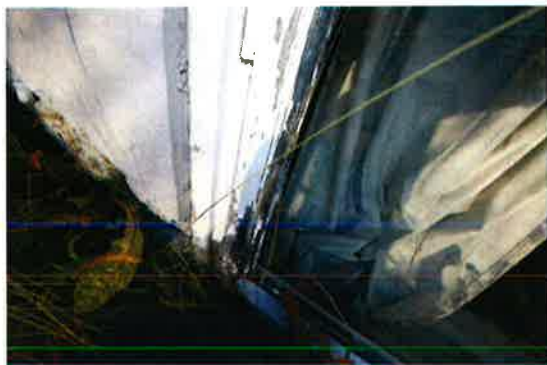
Råteskadet vindu
