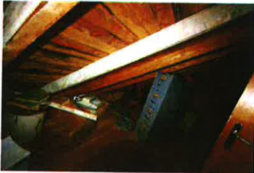
Takkonstruksjon gamle del.
