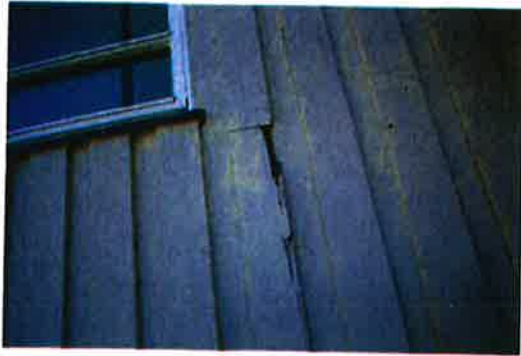
Råteskadet kledning.
