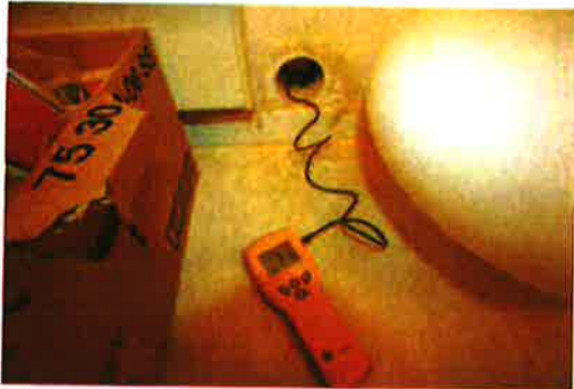
Fuktmåling i Innforet bakvegg u-etg.
