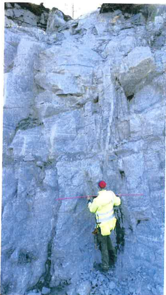
Figur 8: Foto av bergskjæring hvor det er utført sprekkekartlegging. Bergmassen er tettere oppsprukket enn bergmassen rundt.
