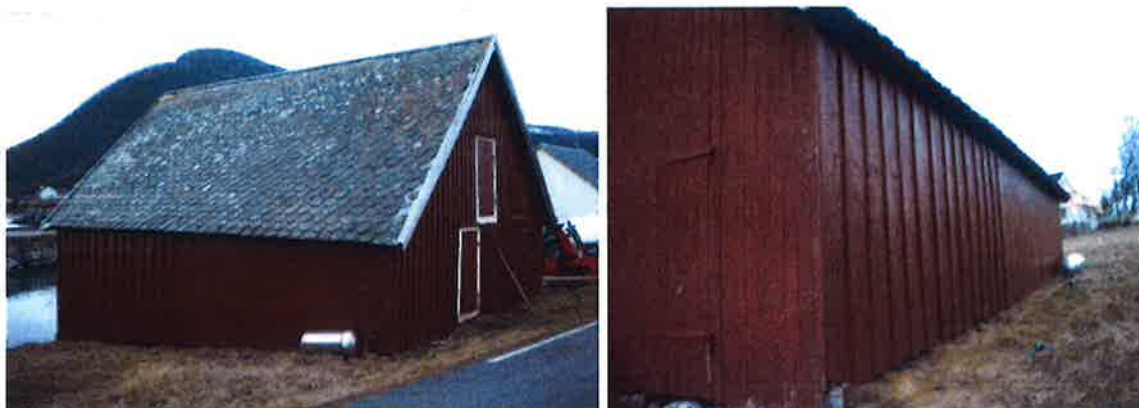
Figur 10 Forskjell mellom den opprinnelige fasaden og den restaurerte delen er synlig – rytmisk og glatt fasade.
