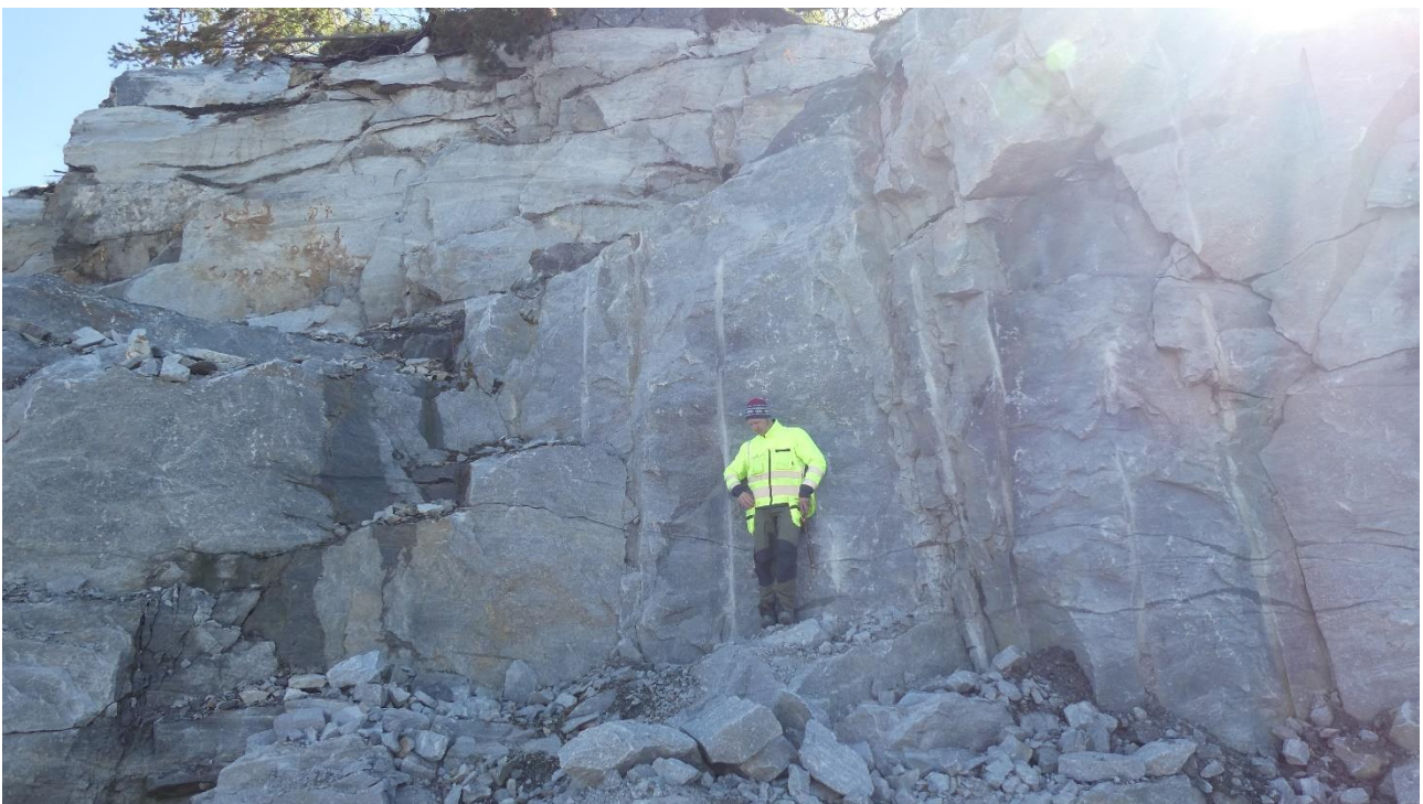
Figur 7: Foto av bergskjæring hvor det er utført sprekkekartlegging. Bergmassen er lite oppsprukket.
