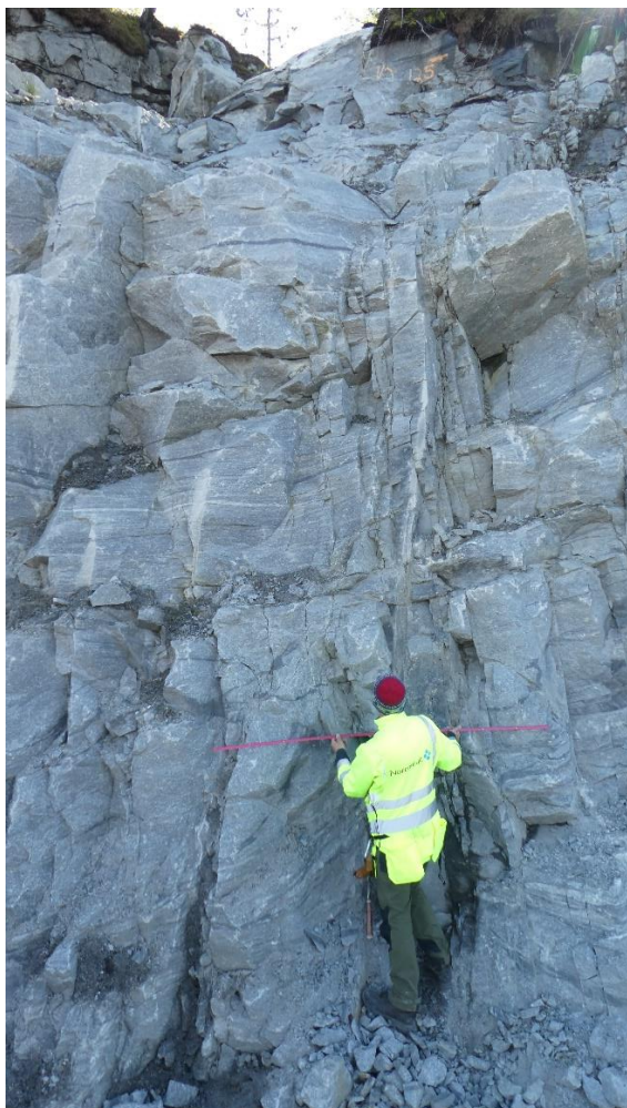
Figur 8: Foto av bergskjæring hvor det er utført sprekkekartlegging. Bergmassen er tettere oppsprukket enn bergmassen rundt.
