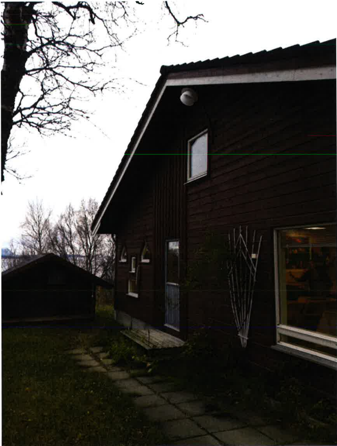
Bytte armatur på eksisterende arm.
