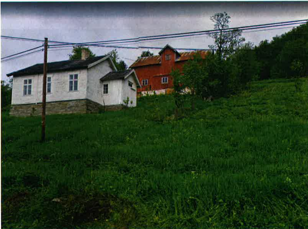
Fjøsene. Bygningen i forgrunn står på egen tomt og omfattes ikke av konsesjonssøknaden.
