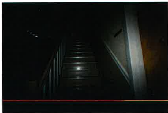
Bratt trapp til 3. etg. Mangler også håndløper ene side.
