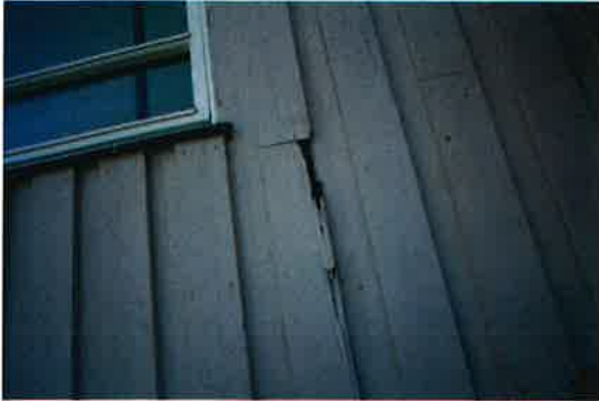
Råteskadet kledning.
