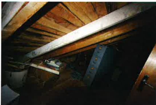
Takkonstruksjon gamle del.
