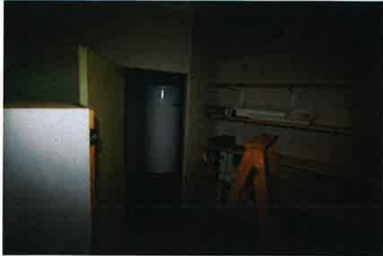
VVT plassert på krakk/bord i kott 3.etg.
