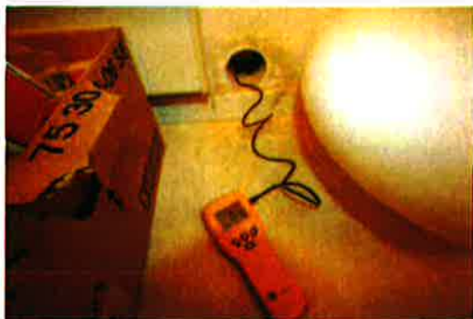
Fuktmåling i Innforet bakvegg u-etg.
