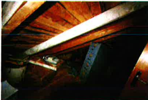
Takkonstruksjon gamle del.
