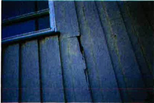
Råteskadet kledning.
