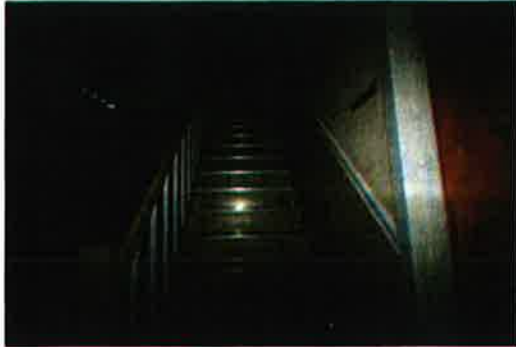
Brett trapp til 3. etg. Mangler også håndløper ene side.
