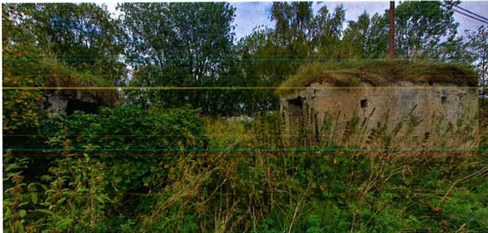
Foto fra befaring 13.09.23. Flere bunkere i området. Innkjørsel til omsøkte tomt er laget rett nord for disse.
