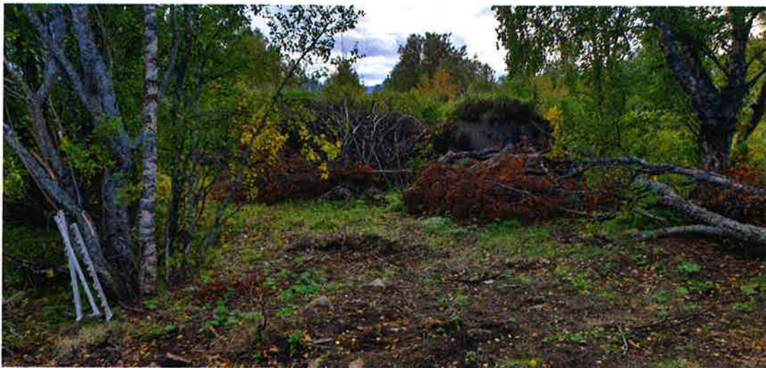
Foto fra befaring 13.09.23. Tomte er planert og massene er skjøvet helt inntil bunkeren.
