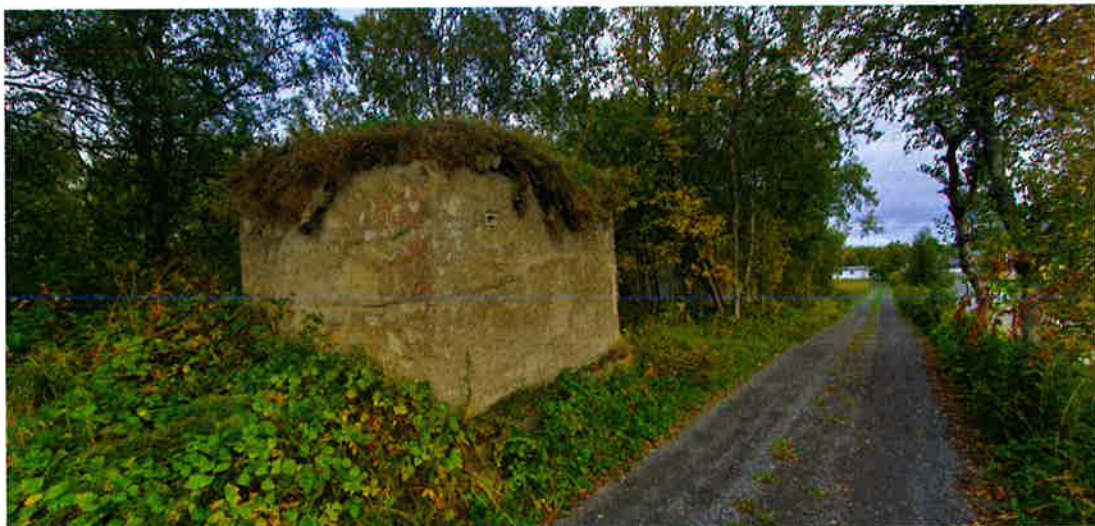
Foto fra befaring 13.09.23. Kystfortet fortsetter i nordøstlig retning fra tomta.
