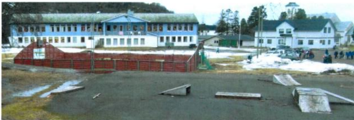
Ballbingen og skateanlegget må flyttes for å gi plass til den nye skolebygningen. I tillegg rives bygningen som huser ungdomsklubben.
