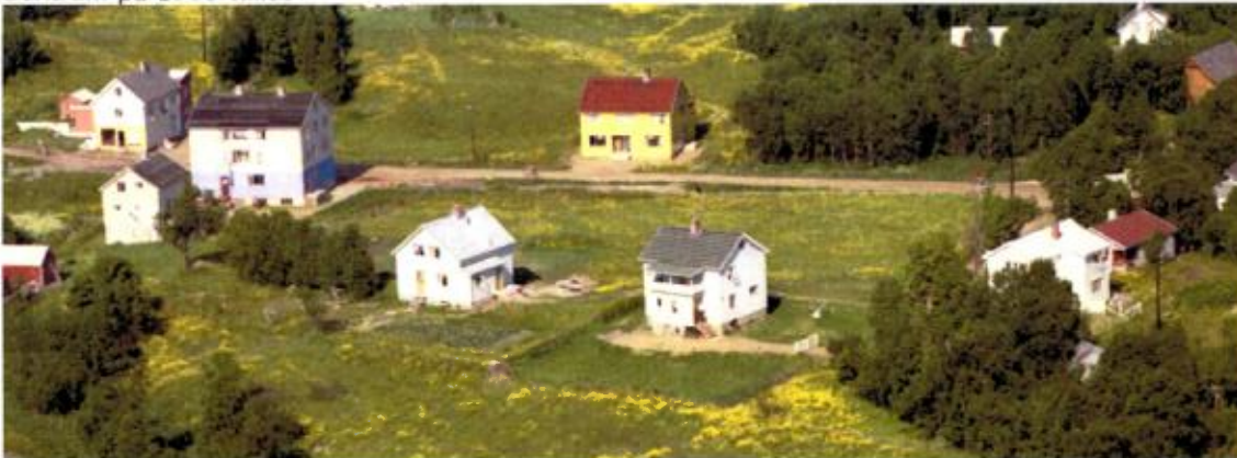
Huset med Galleri Kafé og byggvarehandelen har blitt lagt etter det nye vegløpet, mens de tre husene i forgrunnen er plassert etter gamle veglinjer gjennom området.
