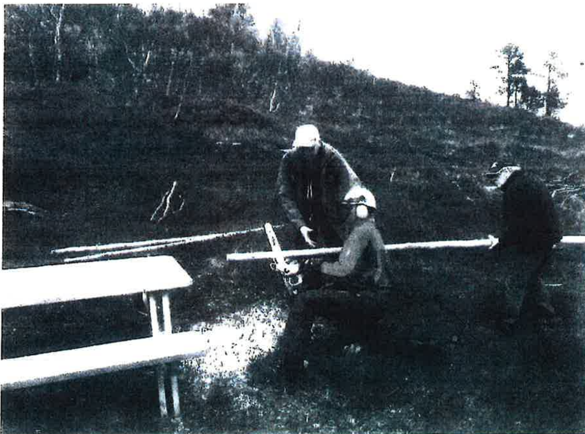
Rune, Nils og Dagfinn i god driv med å bygge "gapahuk" på høgdekulen 2012. Tusen takk gutter for god innsats!
