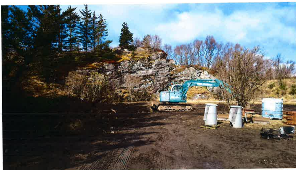
Figur 9 Synlige spor etter steinbrudd på Engenesodden.
