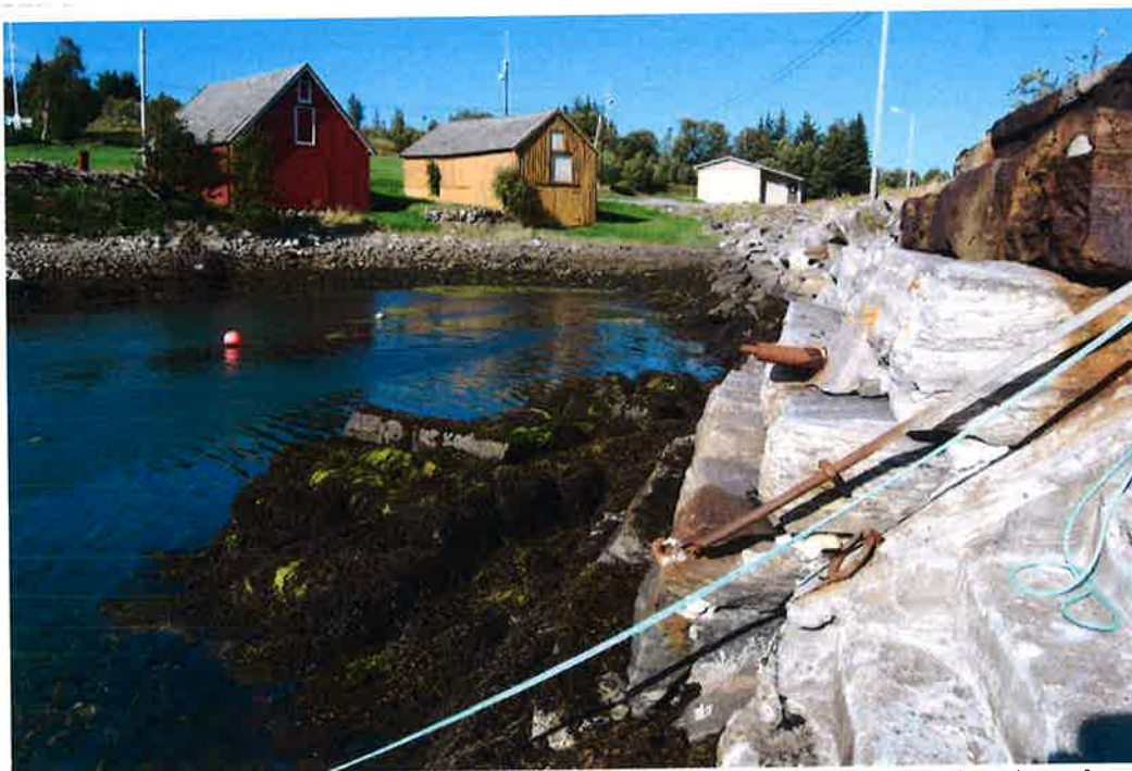
Figur 7. Utsikt over eldre havneområdet som viser hvordan moloen ble bygd oppå en gammel steinkai (mot VNV).
