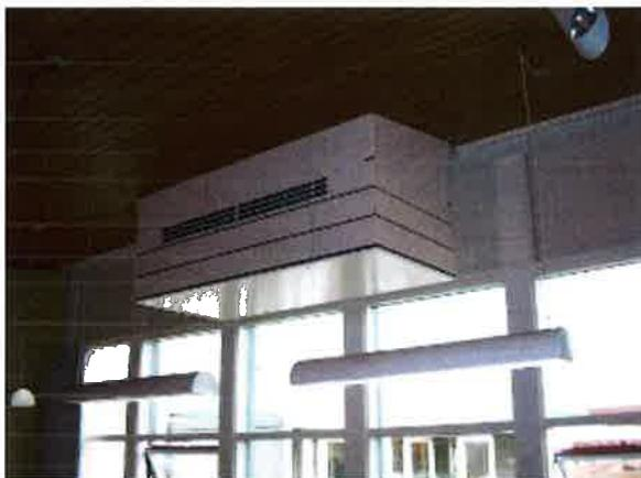
Det finnes i dag en leverandør som leverer romaggragter som kan festes på vegg eller oppunder tak i hvert rom. Enheten kan også fås med kjølemodul dersom det er behov for det. Med en slik løsning unngår en store arealsluk til kanalstrek og kan gå for en åpen løsning uten himling i oppholdsrom.
